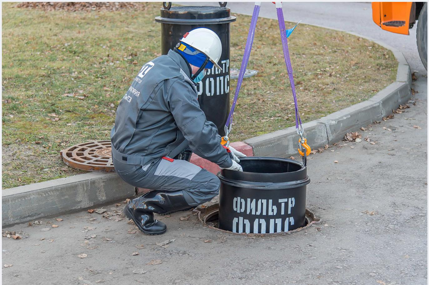
9 декабря около научно-исследовательского корпуса «Технополис Политех» был установлен разработанный в СПбПУ инновационный фильтр очистки поверхностного стока (ФОПС). В ближайшем будущем планируется оснастить новыми фильтрами еще около десятка канализационных люков на этом участке кампуса. Шесть ФОПС функционируют в районе Спортивного комплекса. А самый первый фильтр, экспериментальный, был установлен пять лет назад возле 4 корпуса.
